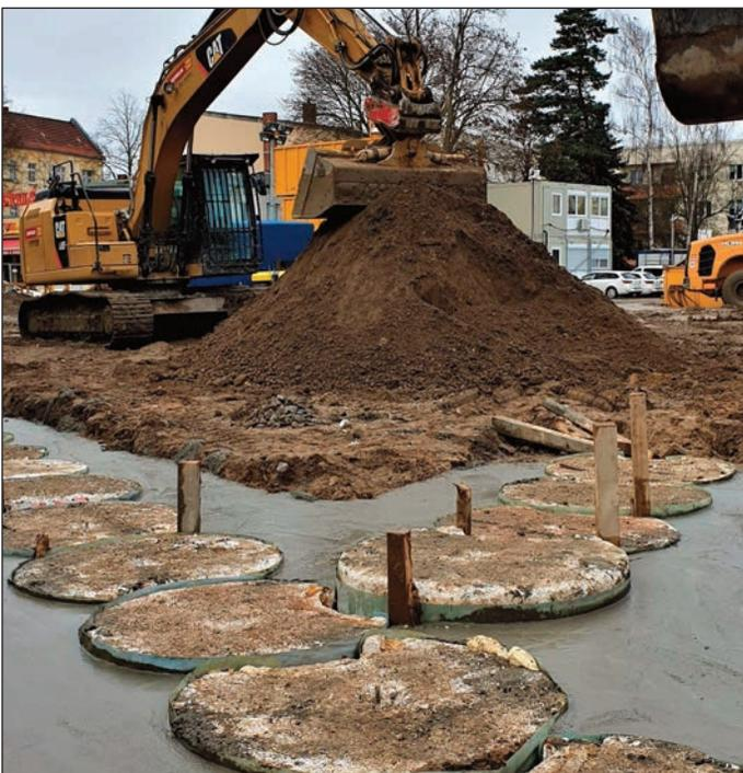
Große Styroporklötze dienen als Schablonen und werden von außen mit Beton vergossen. Nach dem Trocknen werden sie entfernt und die Bohrung kann angesetzt werden.
