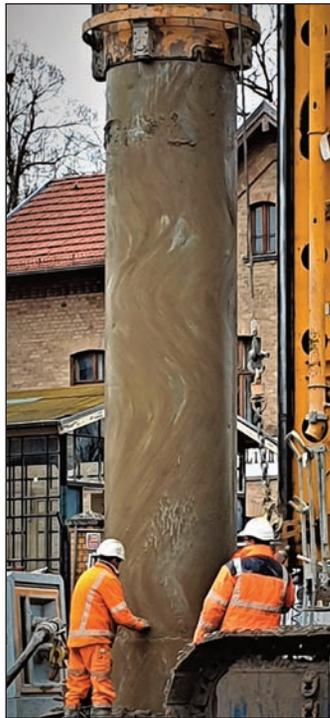
Die verrohrte Bohrung soll den Bruch des Bohrloches verhindern.
